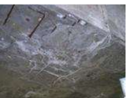
主桁のひび割れ
