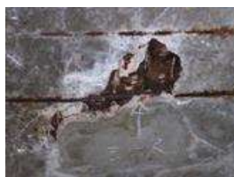
鉄筋の剥離・露出
