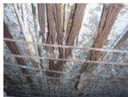
PC ケーブル破断
