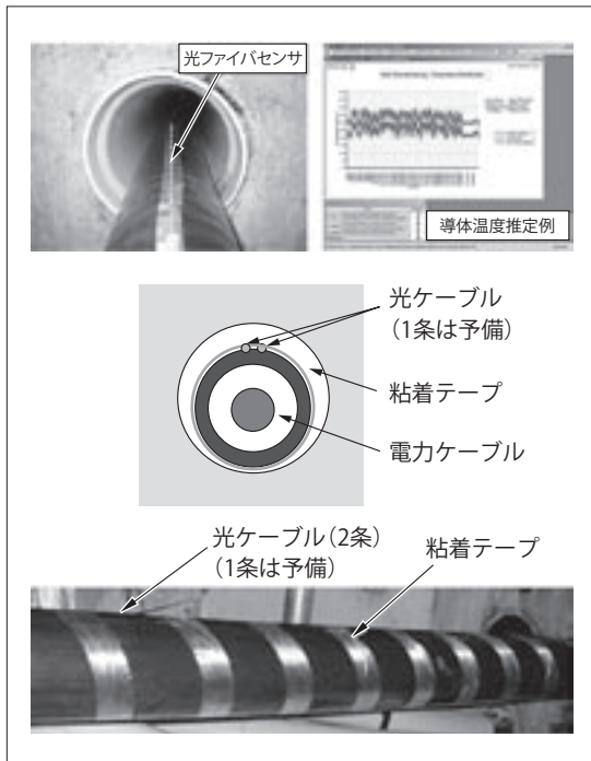
図表—14 電力ケーブル温度管理例
