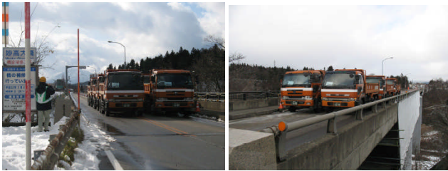
写真6, 7 載荷試験状況
