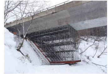
写真8 ステーキング設置
