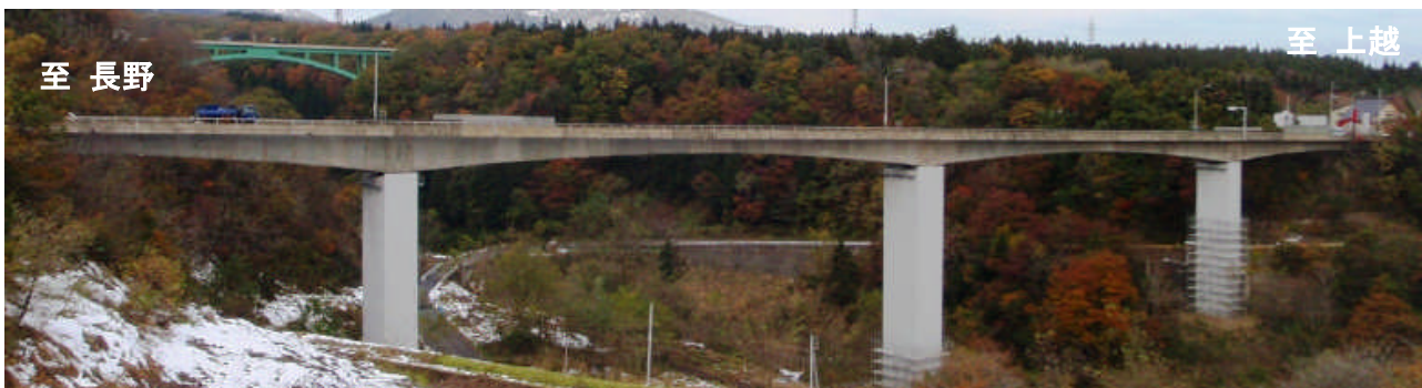
写真1 妙高大橋全景
